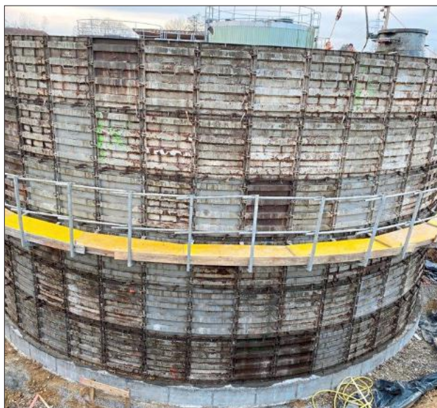
Erste Bauschritte beim Nachklärbecken sind bereits sichtbar.
